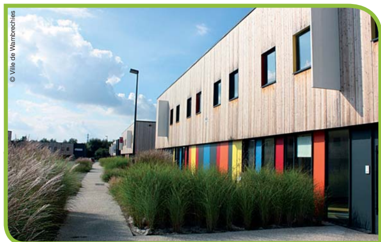
L'Ecopark est constitué de bâtiments tous labellisés HQE.
