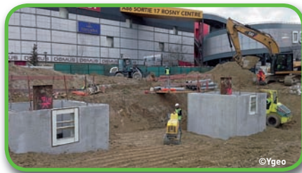
Travaux de forage pour le réseau de géothermie
