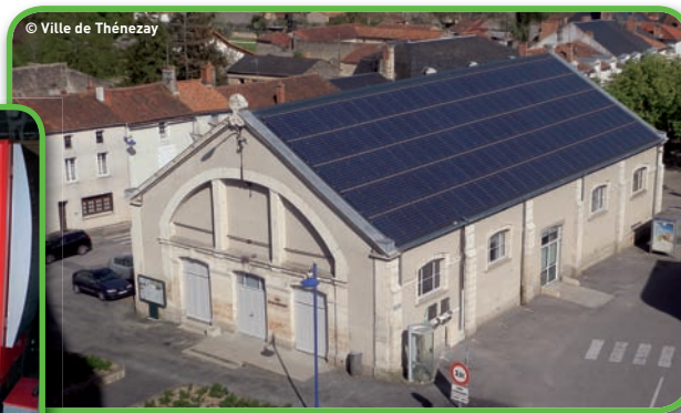
Une installation photovoltaïque au-dessus de la salle Michel-Bonnet
