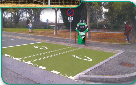
Installation de recharge pour véhicules électriques
