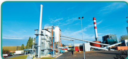
Une chaufferie bois-énergie alimente le réseau de chauffage urbain.
