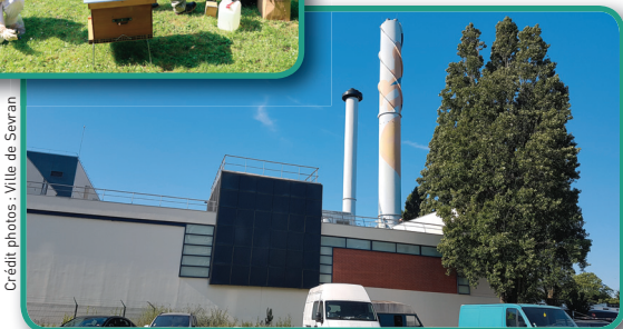
La chaufferie biomasse en fonction depuis un an.
