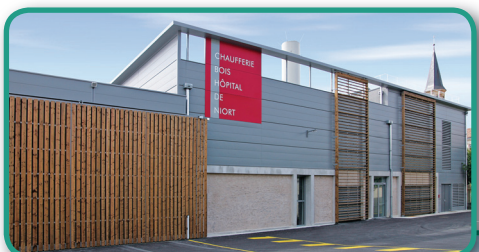
La chaufferie bois de l'hôpital.
