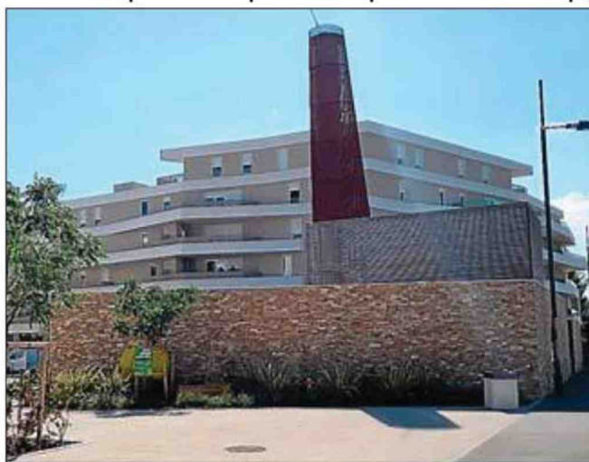
■ La chaufferie biomasse de l'écoquartier « Mas de Rochet ».
