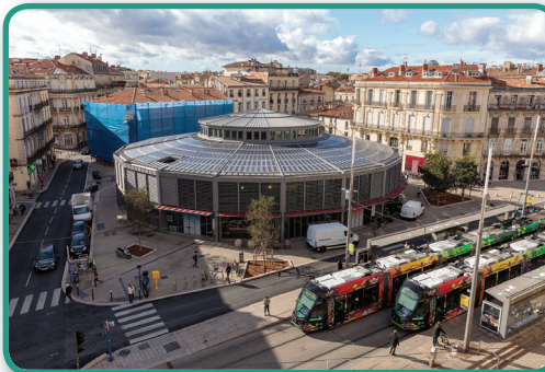
Panneaux photovoltaïques sur les nouvelles Halles Laissac
